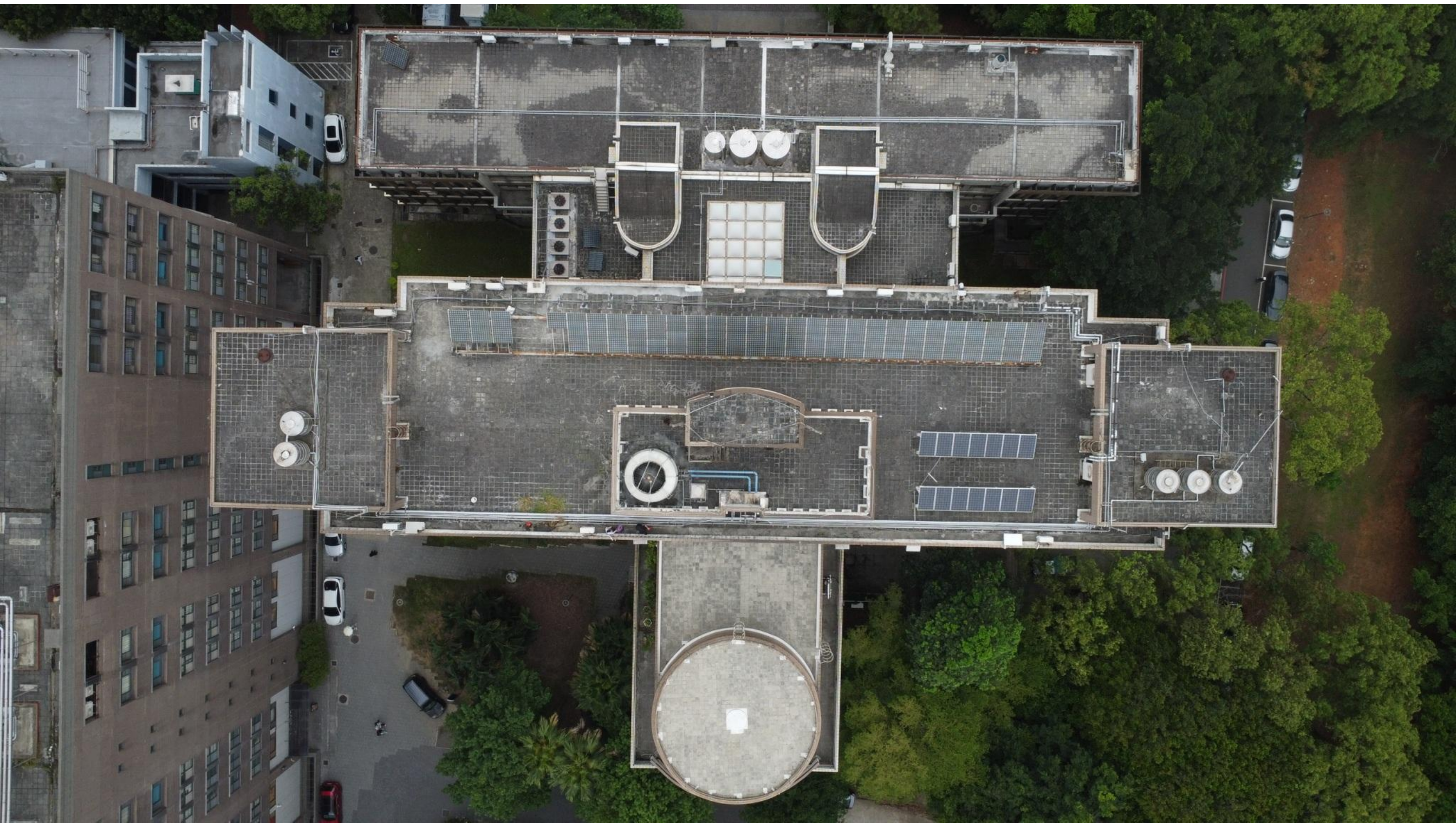
電學大樓及篤信大樓（校園配置圖10、11號建物），現有太陽能板學校自行拆除
