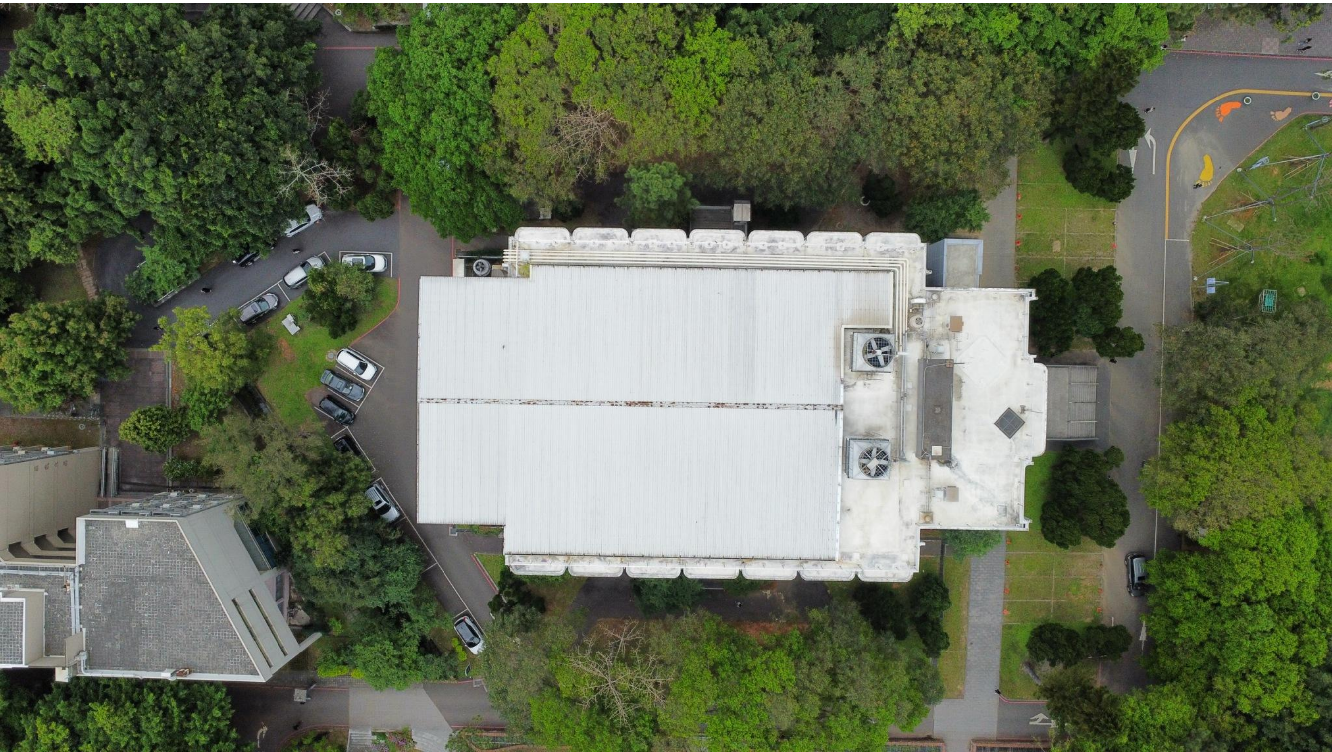
智信樓（校園配置圖12號建物）
